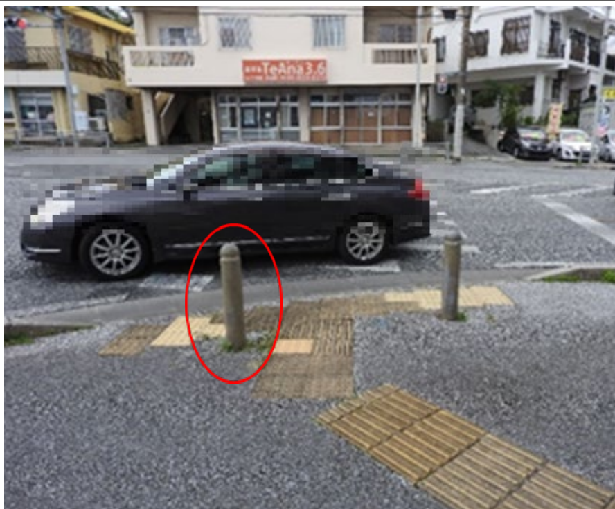
事例④-1 場所：国道331号 沖縄市（高原5丁目） 誘導用ブロックに車止めが近接
