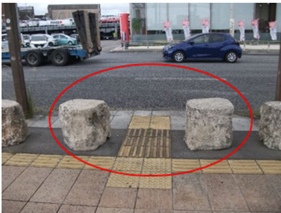
事例④-3 場所：国道329号 沖縄市（農民研修センター前バス停） 誘導用ブロックに障害物が近接
