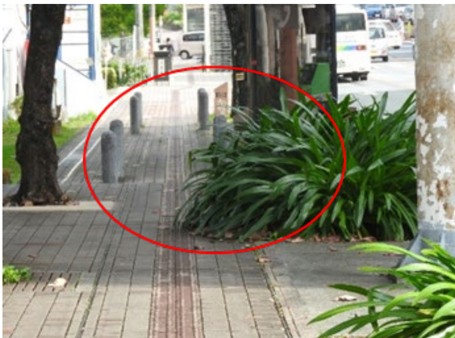
事例④-4 場所：国道58号 那覇市（前島3丁目） 誘導用ブロックに草木が覆い被さっている
