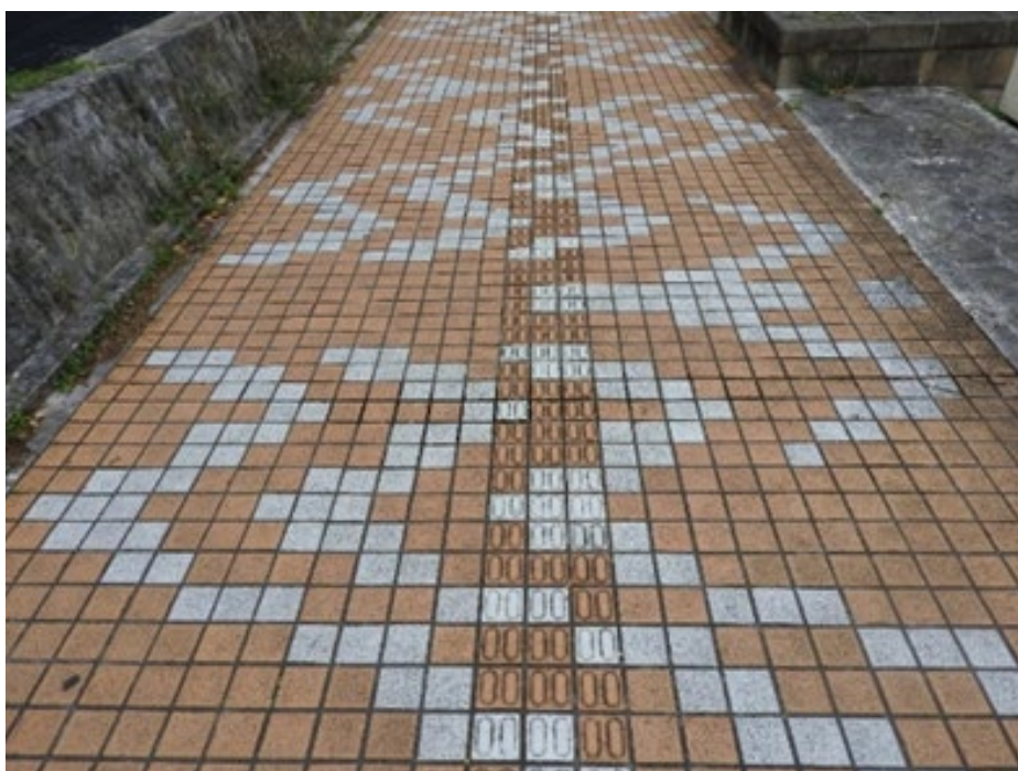
事例⑤-4 場所：県道42号 那覇市（県庁南口交差点付近 重点整備地区）
