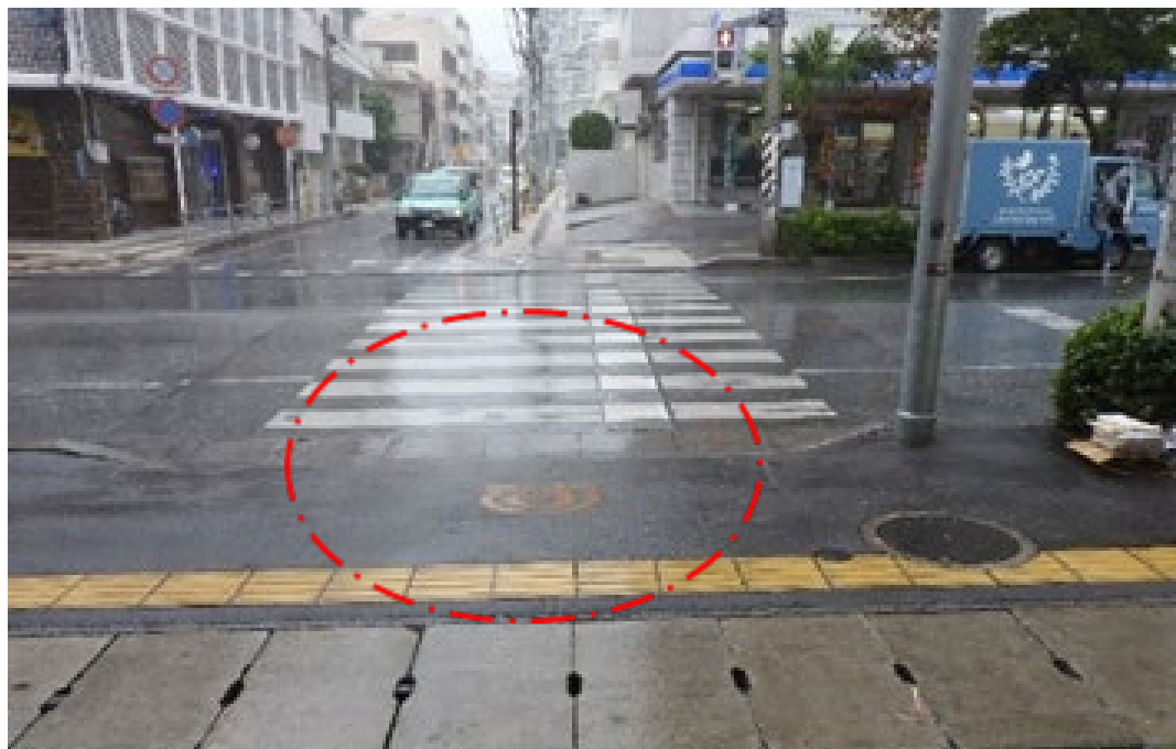
事例①-3 場所：市道 那覇市（泉崎2丁目 重点整備地区） 横断歩道への誘導用ブロック未設置
