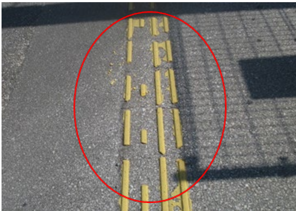
事例⑥-2 場所：国道329号 豊見城市（とよみ大橋付近） 摩耗・破損している
